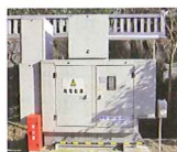
◀停電してもすぐに稼働します。(自家発電機)
