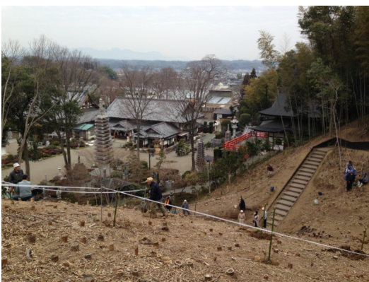
↑ 植樹作業風景
