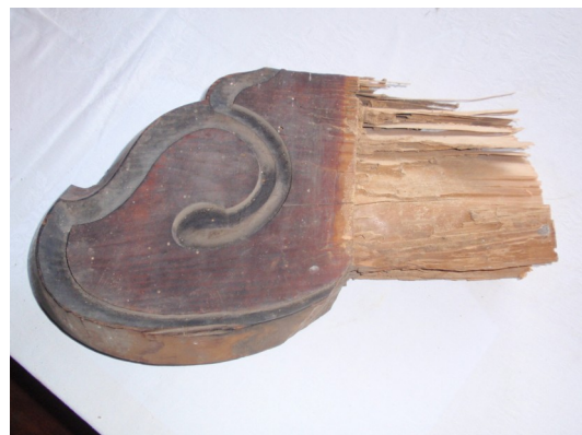
↑ 取替工事を行った痛みの激しい樺製の木鼻（江戸期）
