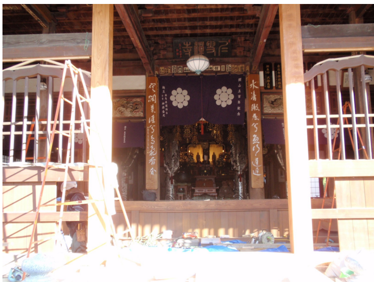
↑ 本堂入口に新しい樺柱が入った直後の様子
