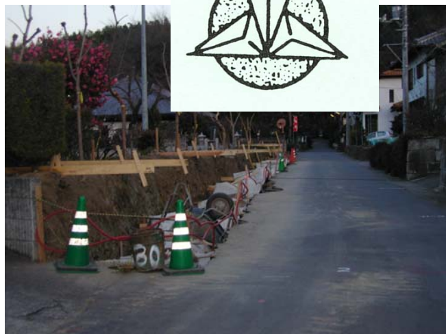
↑ 拡張工事中の仁叟寺参道
